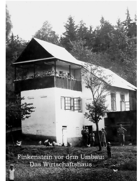
Das Wirtschaftshaus in Finkenstein vor dem Umbau.
